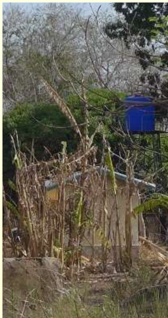
château d'eau fond de cour de Perma, celui-ci est à remplacer pour devenir le château principal pour les cultures et bâtiments
